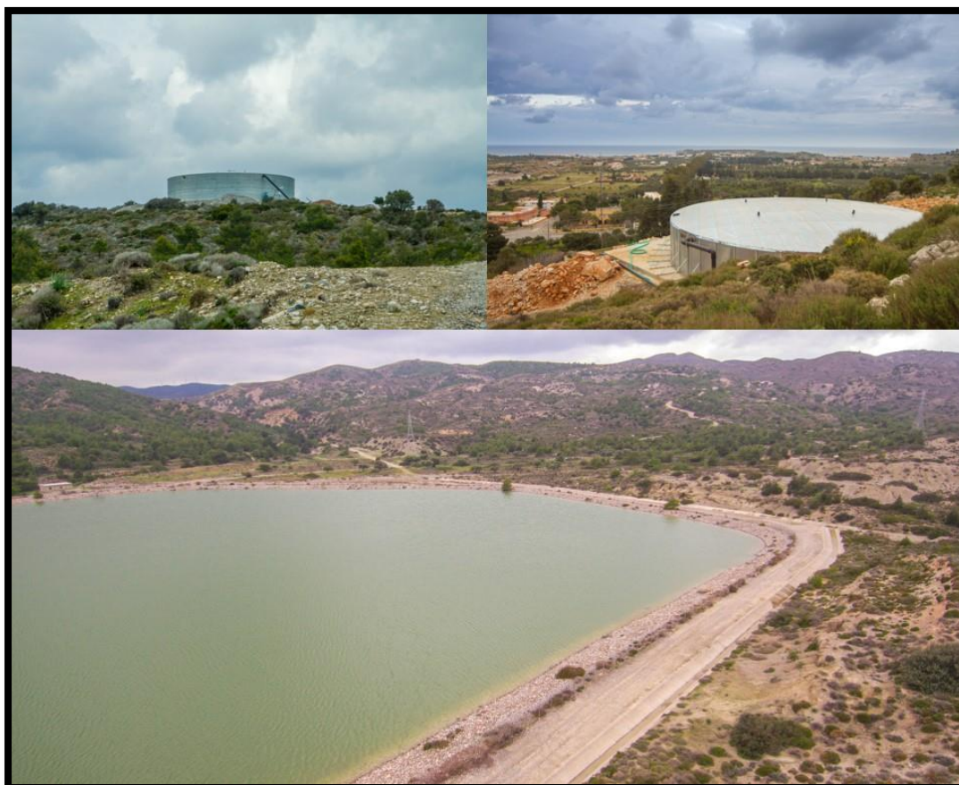
Εικόνα 20 Νέες δεξαμενές ύδρευσης και αποκατάσταση της λιμνοδεξαμενής άρδευσης Σκολονίτη
