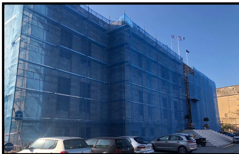
Εικόνα 23 Αποκατάσταση εξωτερικών όψεων Δημαρχιακού Μεγάρου
