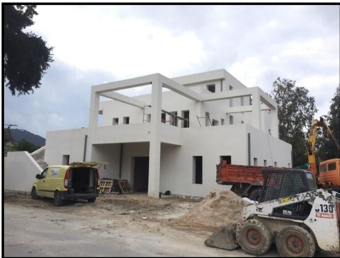
Εικόνα 28 Κατασκευή νέου Βρεφονηπιακού Σταθμού Ιαλυσού
