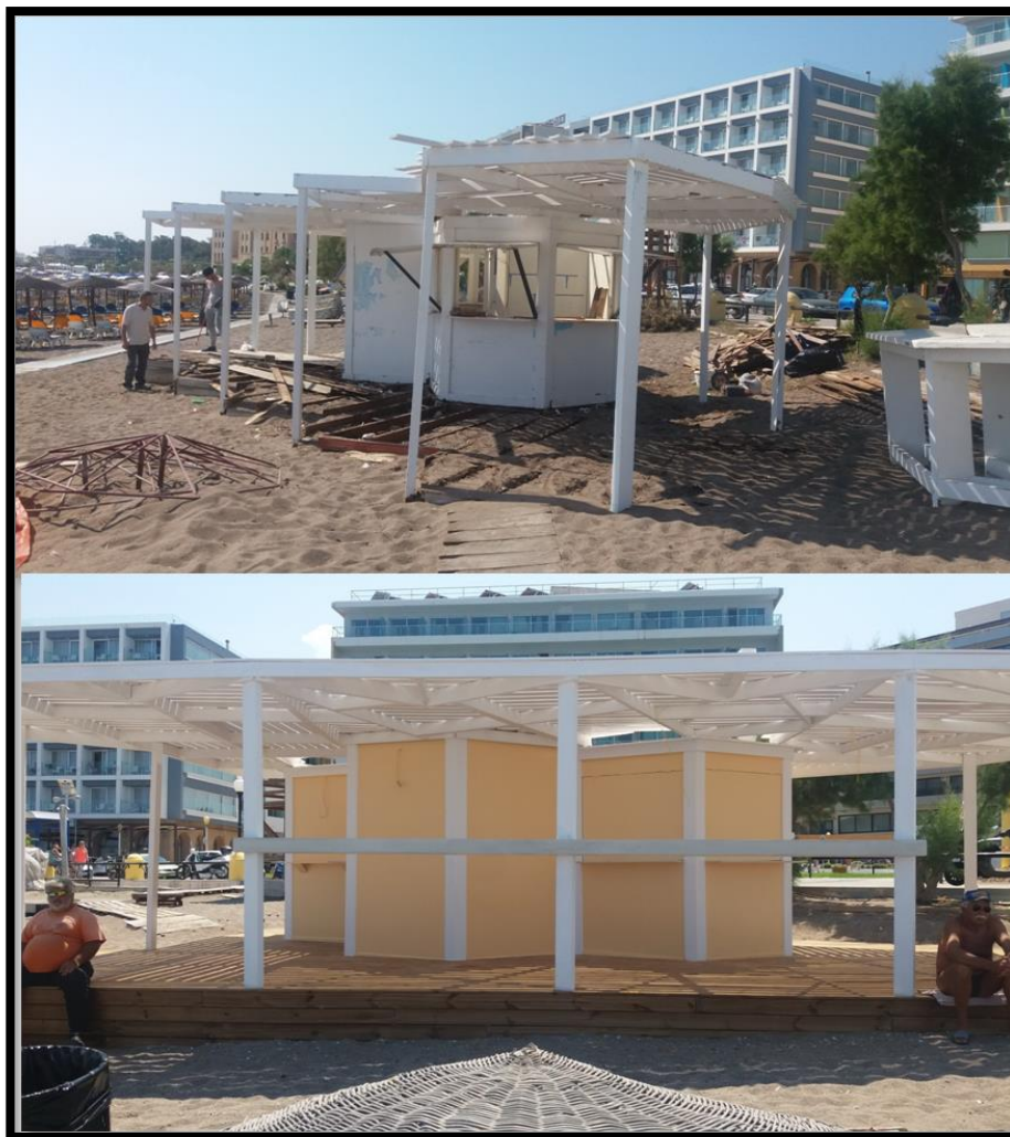
Εικόνα 8 Τοποθέτηση νέας καντίνας στο Ευδρείο
