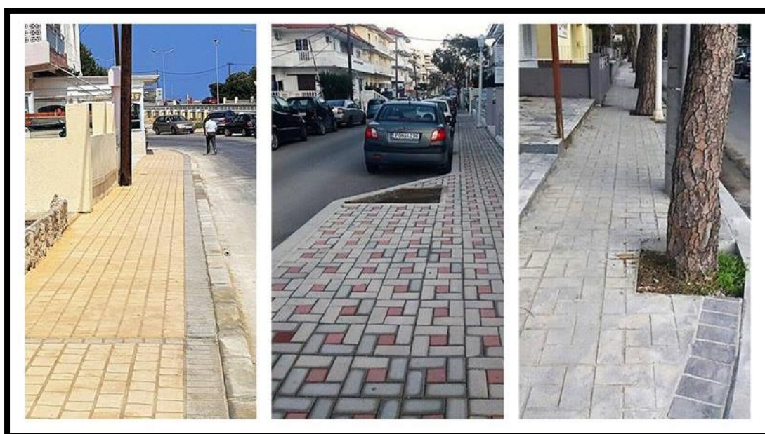
Εικόνα 22 Κατασκευή και ανακατασκευή πεζοδρομίων σε κεντρικές οδούς της πόλης
