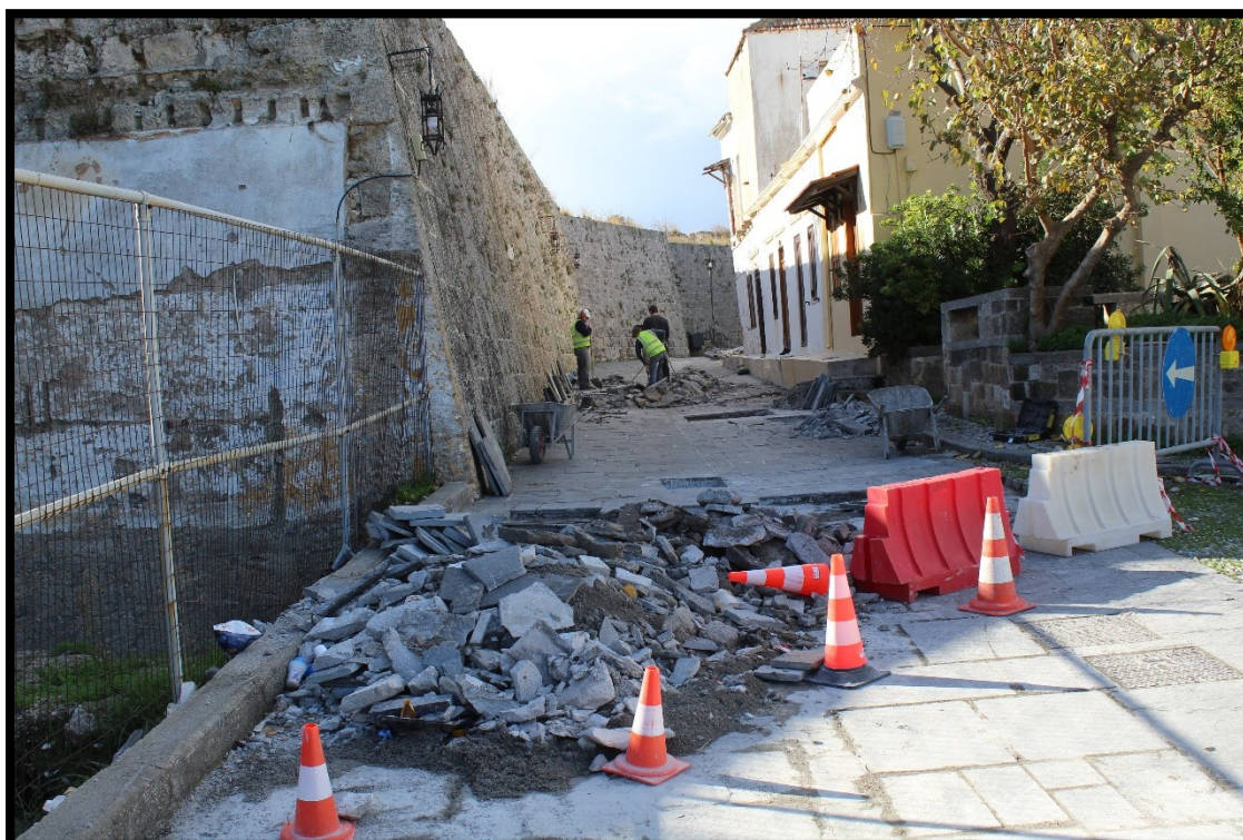
Εικόνα 27 Αποκατάσταση Οδοστρώματος Παλιάς Πόλης
