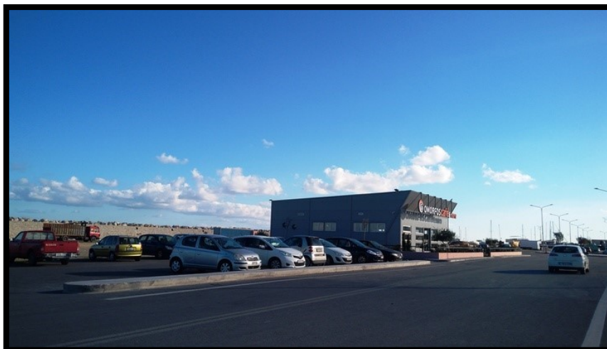
Εικόνα 28 Ολοκλήρωση κατασκευής και διαμόρφωση περιβάλλοντα χώρου επιβατικού σταθμού Ακαντιάς
