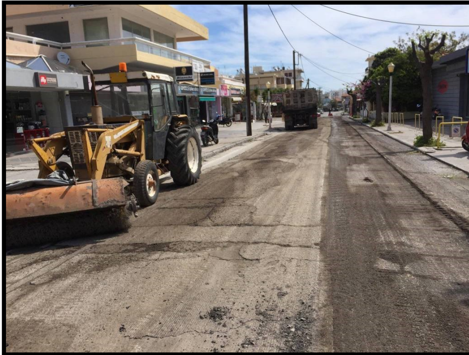
Εικόνα 24 Τοποθέτηση νέου ασφαλτοτάπητα στην περιοχή Μητροπόλεως
