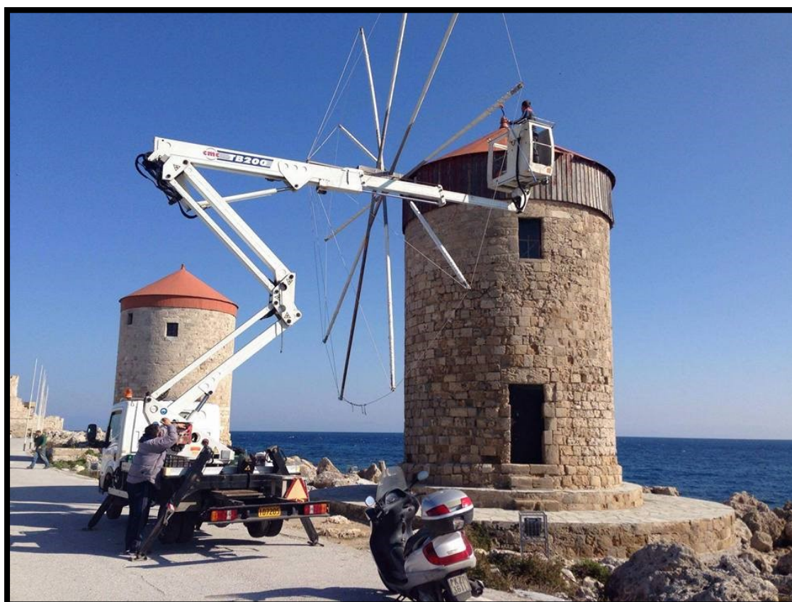
Εικόνα 29 Αποκατάσταση ιστίων ανεμόμυλων
