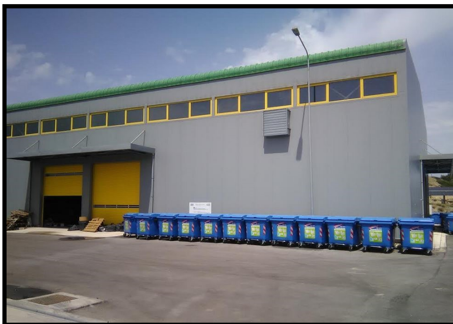
Εικόνα 21 Ολοκλήρωση Κατασκευής ΚΔΑΥ
