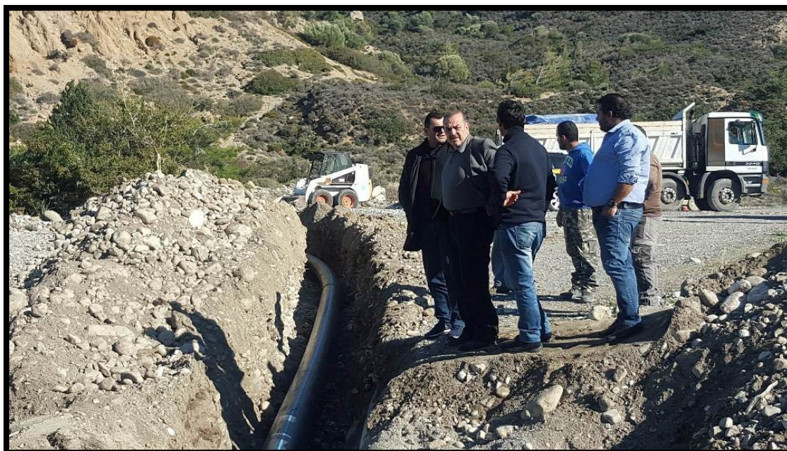
Εικόνα 19 Επισκευή δικτύου άρδευσης λιμνοδεξαμενής Σκολωνίτη
